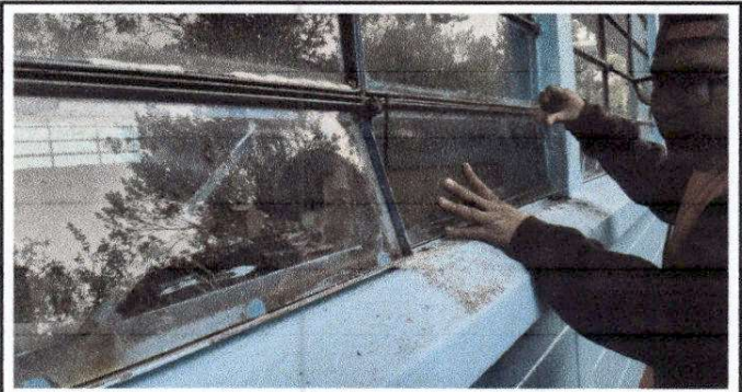
Foto 4: Sustitución de vidrios
