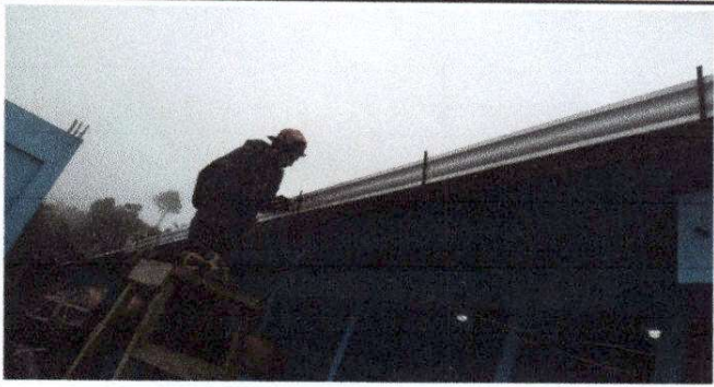
Foto 1: Sustitución de canal de pvc
