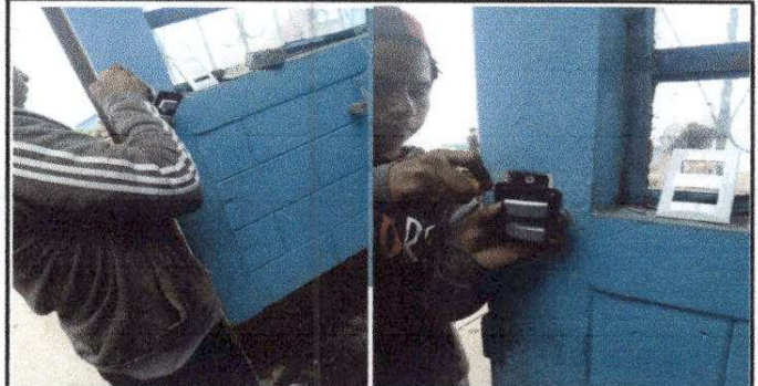
Foto 4: Sustitución de interruptores simples y dobles
