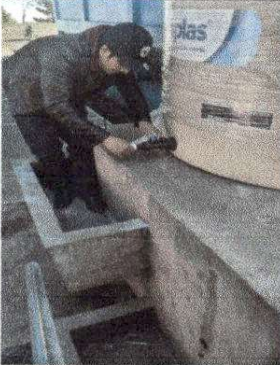
Foto1: Sustitución de llave de chorro
