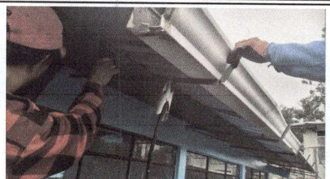
Foto 2: Sustitucion de soporte o pescante de metal para canal
