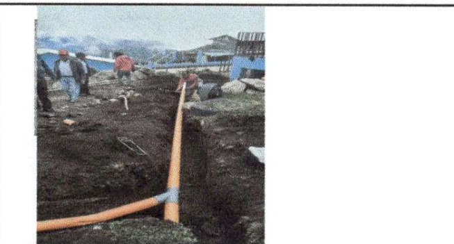
Foto 5: Sustitución de tubería PVC línea principal aguas negras
