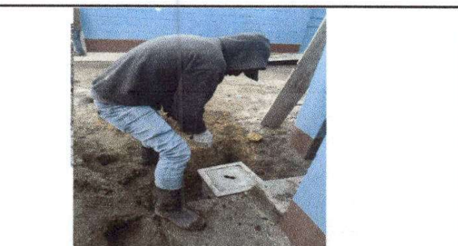
Foto 6: Sustitución de caja de registro
