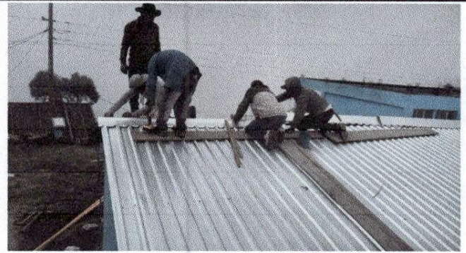
Foto 2: Sustitucion de capote de lámina para lámina troquelada
