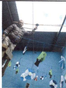
Foto 2: Sustitución de lamparas tipo LED
