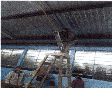
Foto 3: Sustitución de plafoneras
