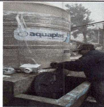
Foto 6: Sustitución de depósito de agua 1700 lt
