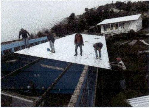
Foto1: Sustitucion de lámina, por lámina troquelada aluzing calibre 26
