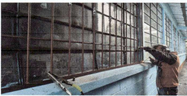
Foto 5: Sustitución de balcones de metal
