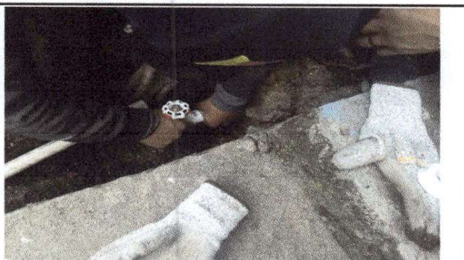
Foto 4: Sustitución de llave de paso
